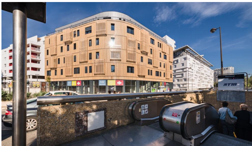
Ywood business – Les Docks libres Marseille – 4 000 m 2 - 1 bâtiment en R+6
